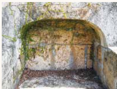
美しく見事なアーチには、首里城の歓会門と同じ「三心円弧」という高度なアーチ技術が使われている
