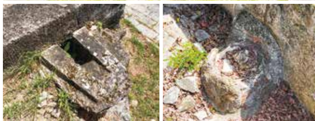
前方にあるトゥーシヌミー。ここで用を足すと豚のいるエリアに排泄物が流れ落ちていく仕組み。ここに人糞以外の餌を入れていた
